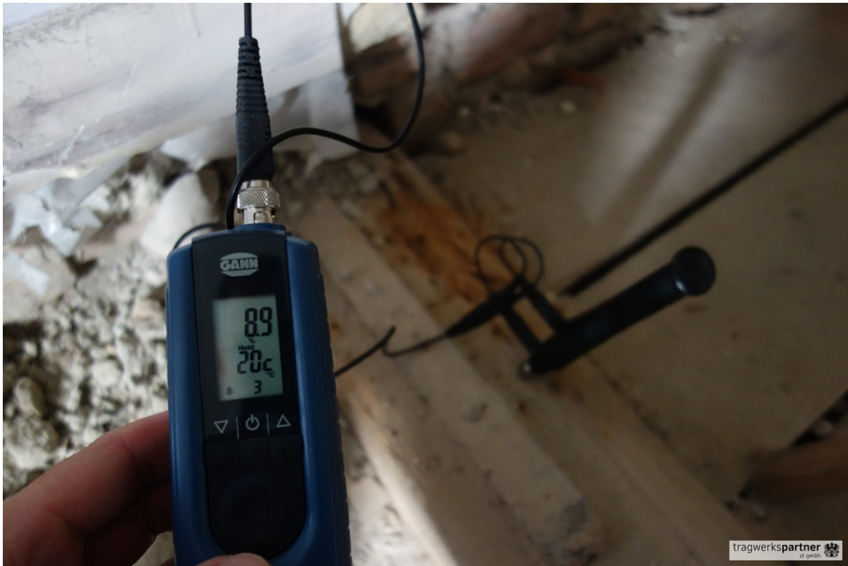
Abbildung 7: Holzfeuchtemessung im (geöffneten) Deckentram in Auflagernähe (Nord)
