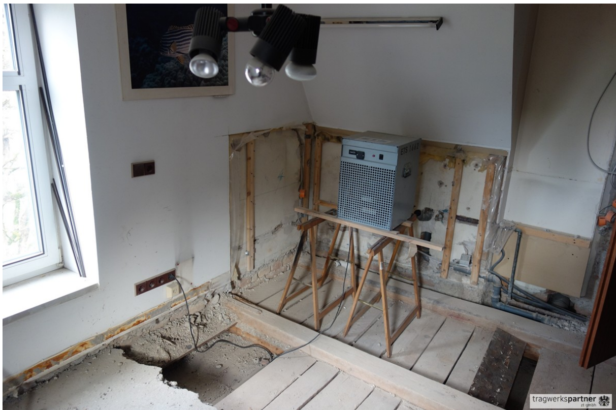
Abbildung 4: Innensituation Ecke Nord-Ost
