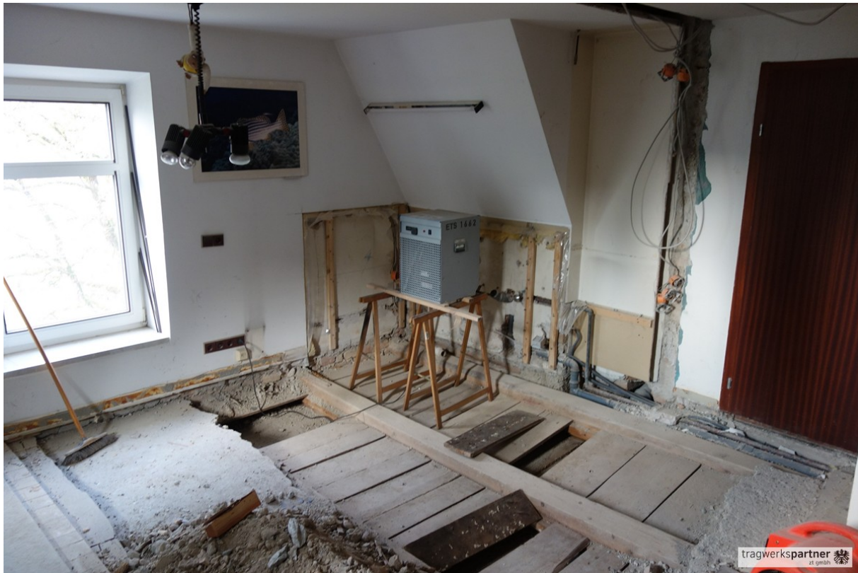
Abbildung 3: Innensituation Ecke Nord-Ost
