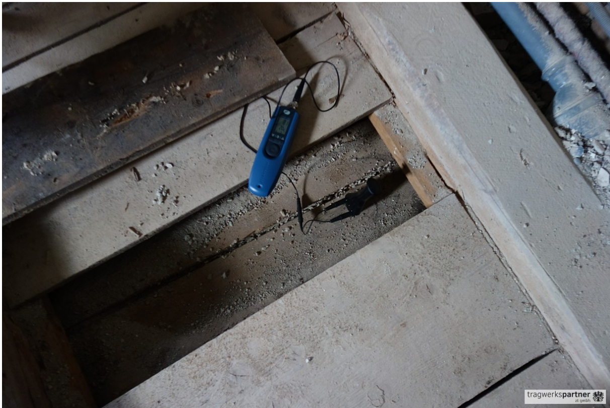
Abbildung 5: Holzfeuchtemessung im (geöffneten) Fußbodenaufbau in „Feldmitte“
