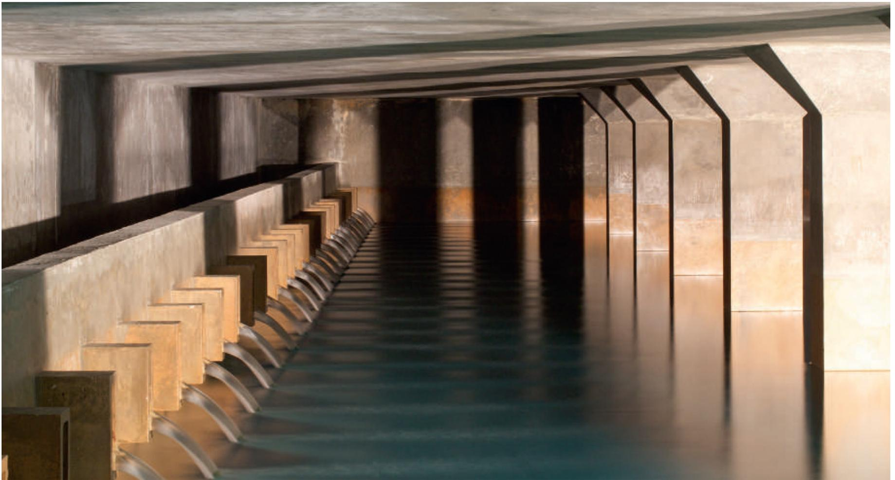
In Hochbehältern wird Trinkwasser gespeichert und je nach Bedarf in das Netz eingespeist – hier: Hochbehälter Mühlau (IKB AG).
