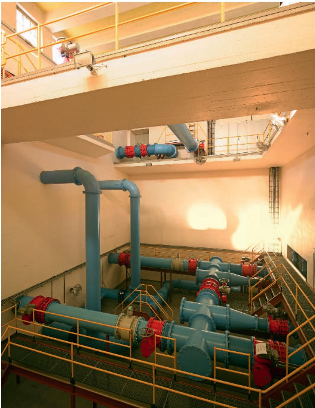
Zwischen Speicherung des Trinkwassers im Hochbehälter und Abgabe in das Ortsnetz – Schieberkammer im Hochbehälter Mühlau (IKB AG).
