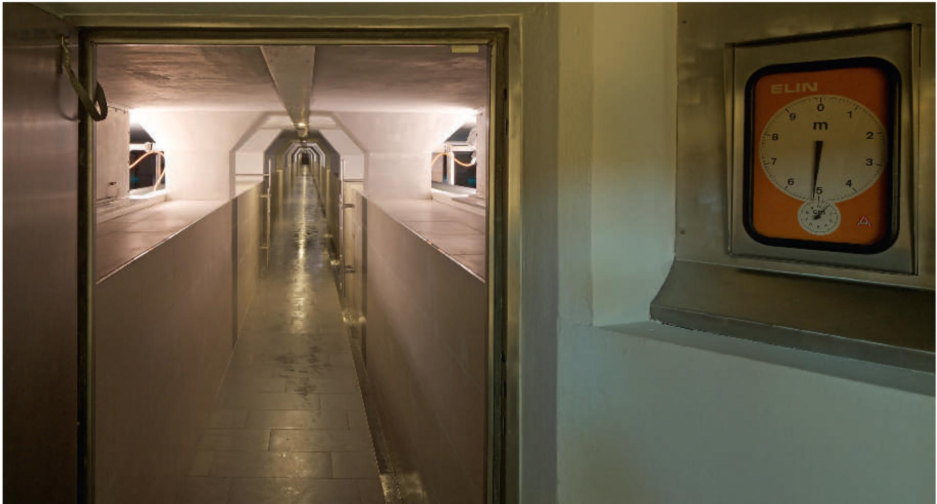
Stabiler Anlagenbetrieb setzt Informationen über Betriebszustände voraus – z. B.: Anzeige des Wasserspiegels im Hochbehälter Mühlau (IKB AG).
