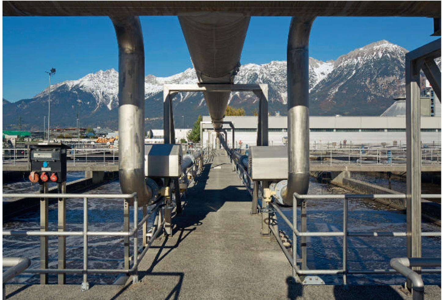
Rohrleitungen dienen auch der Zufuhr des Sauerstoffs für die biologische Abwasserreinigung – hier: Kläranlage Innsbruck (IKB AG).
