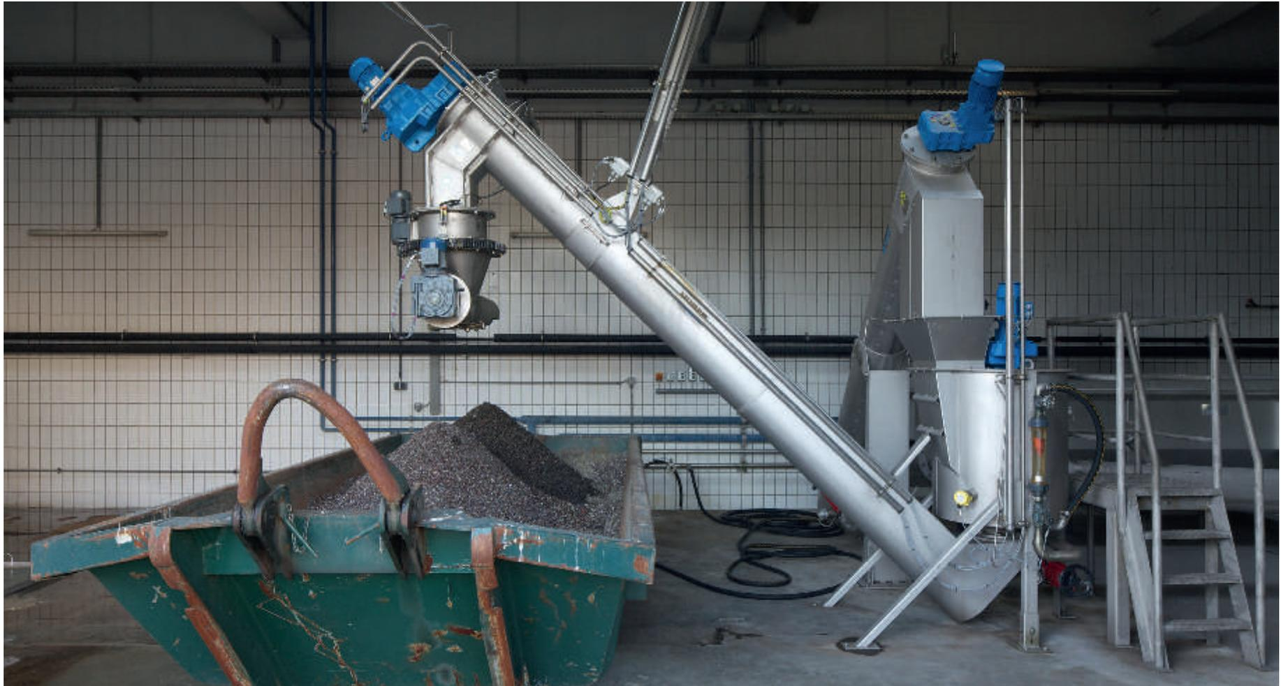
Im Zuge der Abwasserreinigung fallen verschiedene Feststoffe an, die ordnungsgemäß zu entsorgen sind (Kläranlage Innsbruck, IKB AG).
