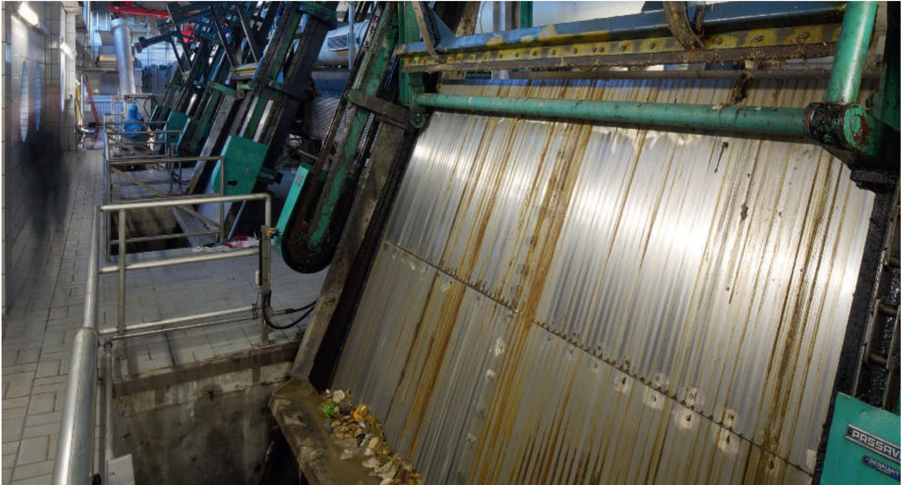
Grobstoffe sind am Beginn der Abwasserreinigung aus dem Abwasser zu entfernen – hier: Rechenanlage der Kläranlage Innsbruck (IKB AG).
