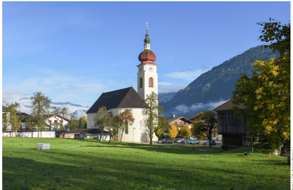
Die Pfarrkirche von Ried im Zillertal
