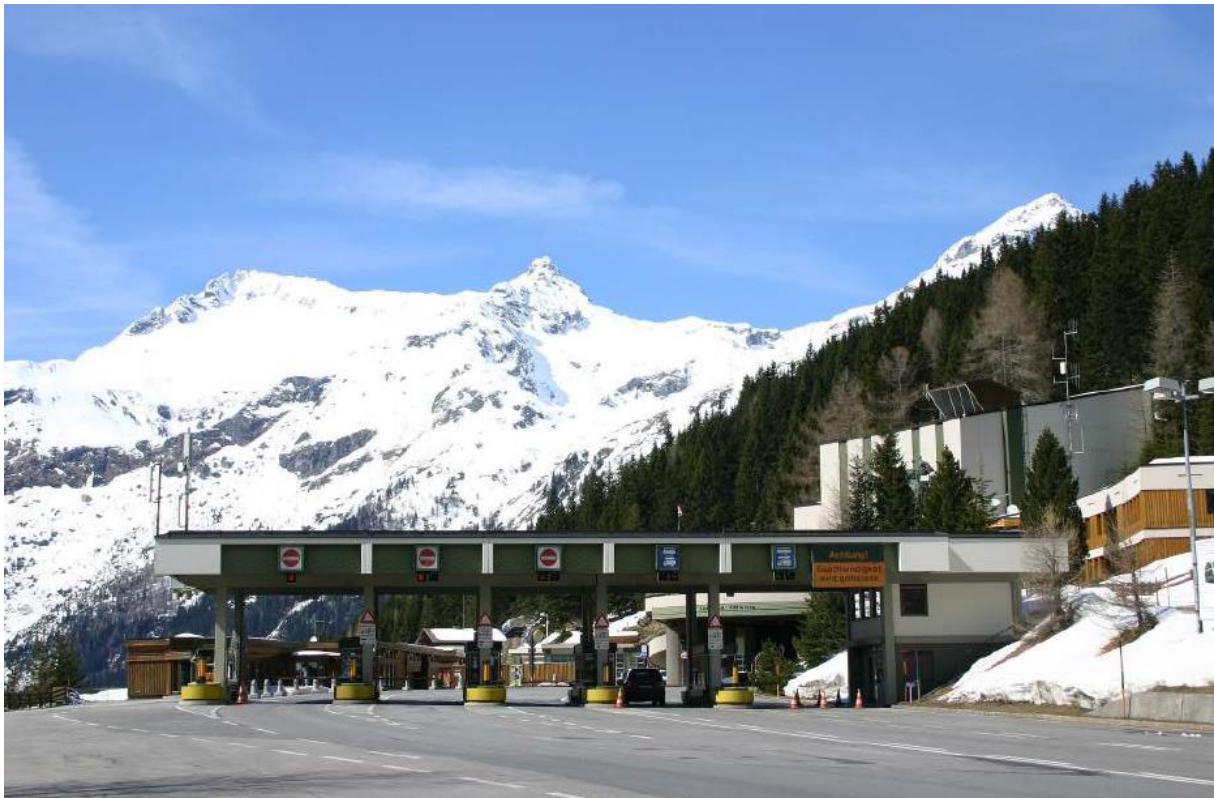
Bild 4: Portal des Felber-Tauern-Tunnels auf Osttiroler Seite
