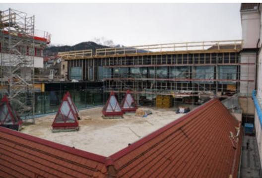
brückenähnlich aufgeständerter, in der Endausführung räumlich transparenter Bauteil, also der neue Lesesaal, dessen öffentlicher Zugang von Norden über den Haupteingang des Altbaus beibehalten wird. Diese Brücke wurde dann mit einem Dach und einem Boden - beides aus Holz - versehen. Bis Jahresende erfolgte die Montage der ost- und westseitigen Fensterfronten und damit war dieser Baukörper vollständig geschlossen.
