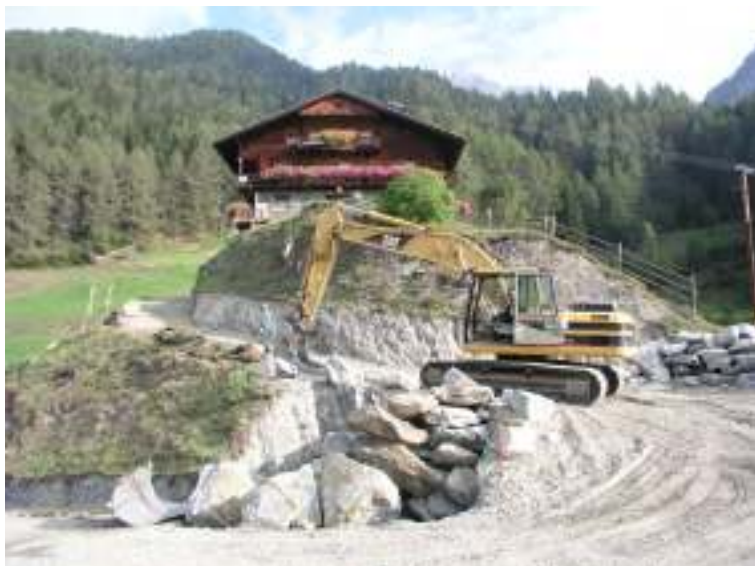
Wegbauarbeiten unterhalb des Hofes „Egger“ ...
