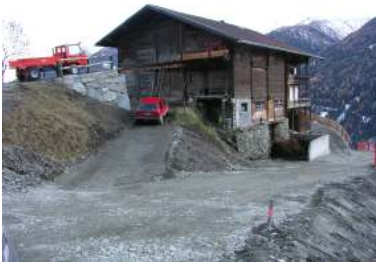
... Tragschichteinbau im Bereich des Hofraumes ....
