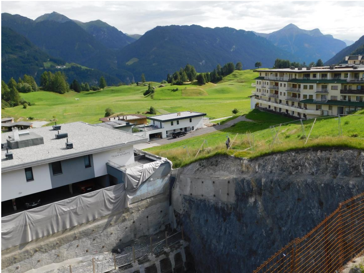
Abb. 4: Ein Beispiel aus Serfaus, stellvertretend für die gesamte Sonnenterrasse: Die sickertfähige Vegetationsdecke ist nur dünn, darunter schließt dichtes Schiefergestein des Engadiner Fensters an
