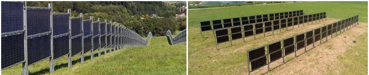
Abb. 5: PV-Freiflächenanlage aus bifazialen Modulen – Beispiel Donaueschingen (links) und Aubrugg (rechts)
