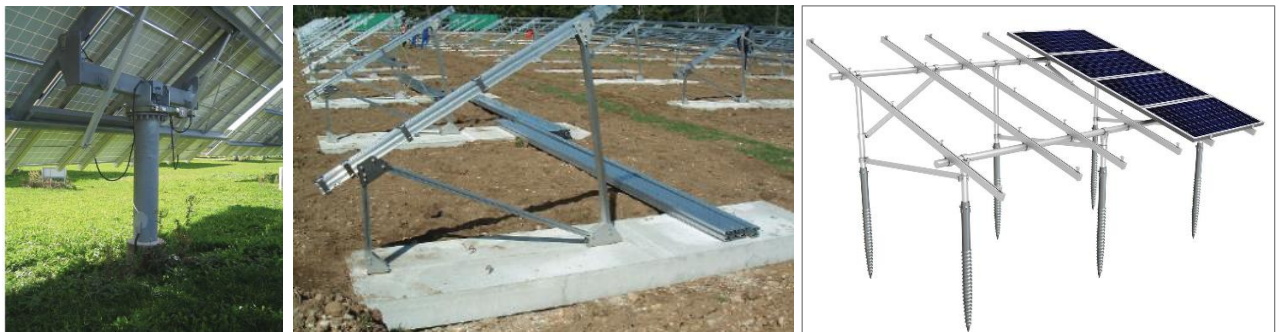
Abb. 6: Rammprofil, Fundament aus Beton und Erdschraub-Anker (v.l.n.r.)
