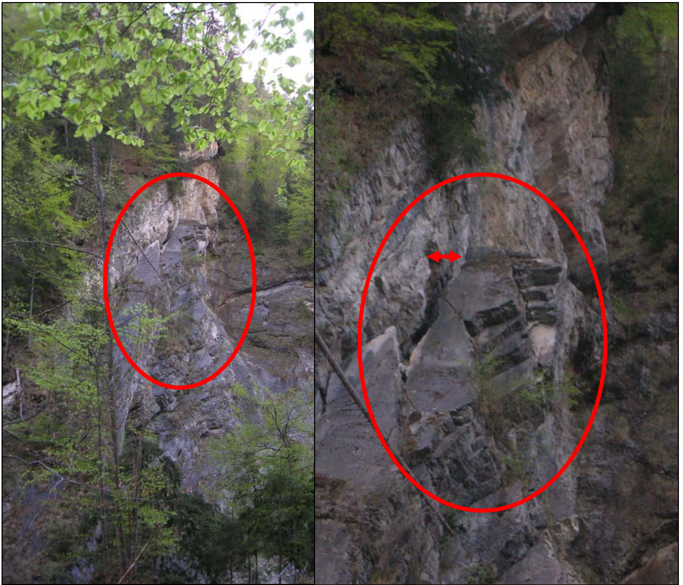
Foto 1: Das vom Absturz bedrohte Felspaket vom Fußsteig aus gesehen. Im rechten Bild mit rotem Pfeil markiert jener Bereich, an welchem sich das Paket bereits gelöst hat.
