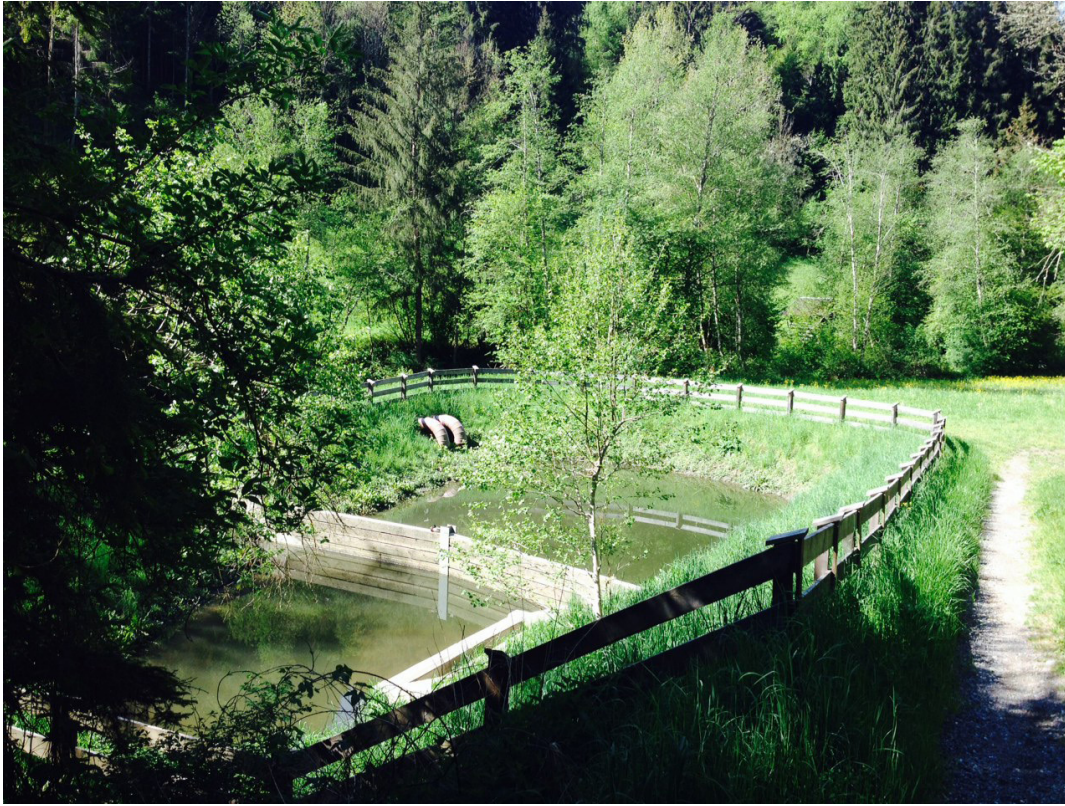
Straßenentwässerung: Bodenfilterbecken mit Absetzraum, ausgeführt mit Notüberlauf mit Tauchbogen und Einlaufbauwerk
