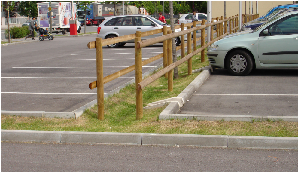
Muldenentwässerung mit Einlaufbauwerken und Abgrenzung
