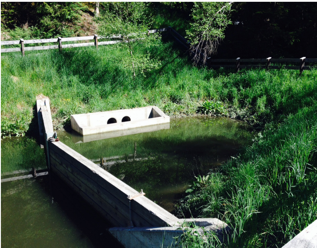
Straßenentwässerung: Bodenfilterbecken mit Absetzraum, ausgeführt mit Notüberlauf mit Tauchbogen und Einlaufbauwerk
