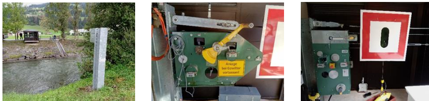
Fotos: Hydrographischer Dienst, Land Tirol; Pegel Rabland/Drau, alte Windentechnik, neue Windentechnik
