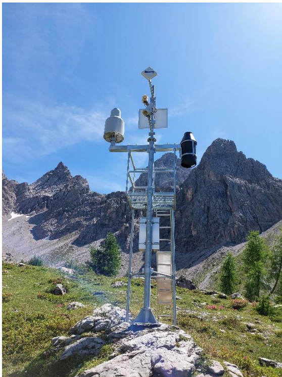
Foto: Hydrographischer Dienst/Land Tirol, Niederschlagsmessstelle Karlsbader Hütte; Ombrometer, Ombrograph, Schneehöhenmessung, Lufttemperatur
