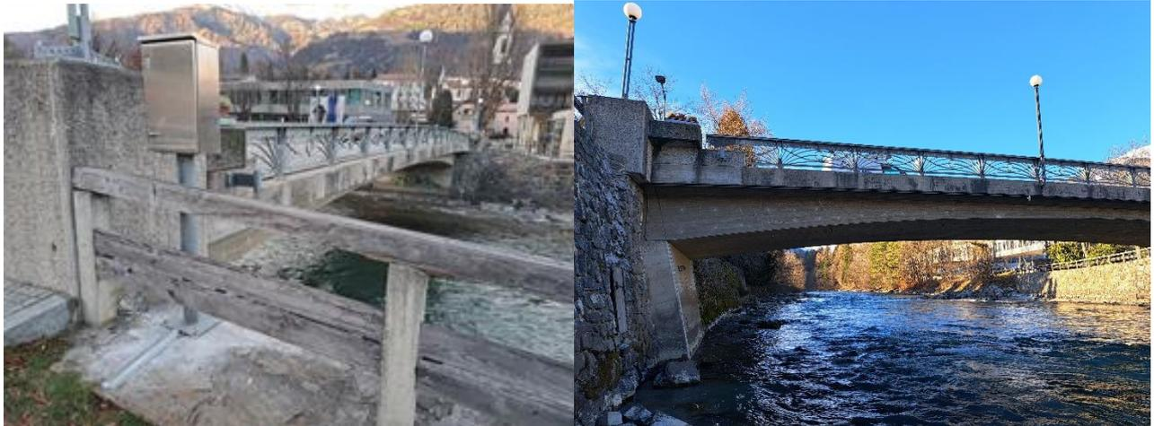
Fotos: Hydrographischer Dienst, Land Tirol; linkes Bild: Schaltkasten mit Datenregistrierung, rechtes Bild: Pfarrbrücke mit Radar im Bereich links unterhalb des Mastens Strassenbeleuchtung (rechts im Bild) sowie Fühlerleitung für Wasserstand und Wassertemperatur am Brückenfundament (links im Bild).
