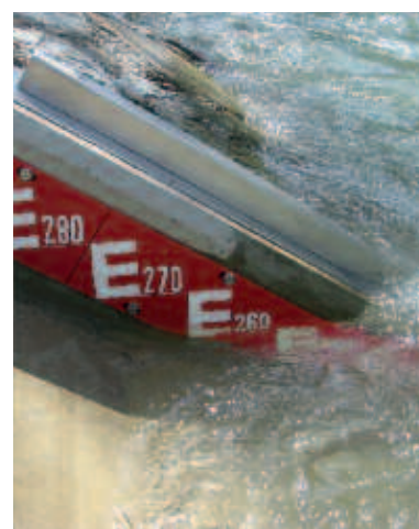
Lattenpegel, das Herzstück einer Pegelanlage
