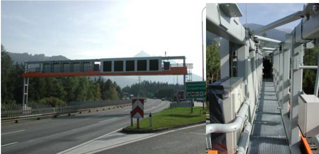
Abbildung 1-29: VBA-Anzeigequerschnitt A13 Europabrücke
