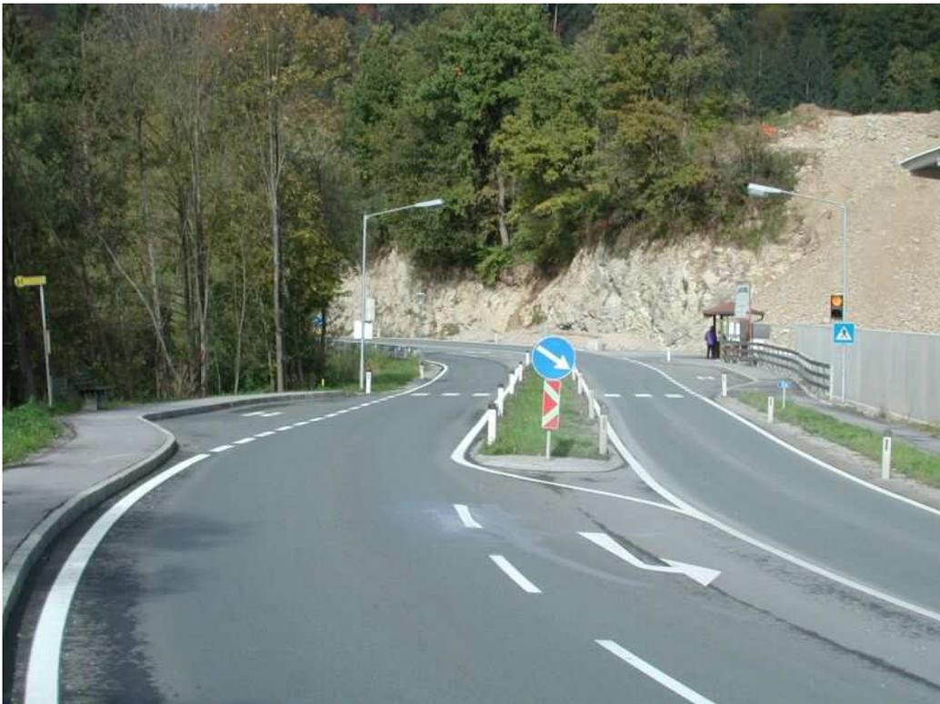
Bei dieser Bushaltestelle wurde auf die Forderungen der Norm entsprechend der Anwendungskriterien bei Hauptverkehrsstraßen eingegangen. Weiters wurde hier auf einen sicheren Zugang für Busbenützer sowie Querungsstelle samt Beleuchtung geachtet.
